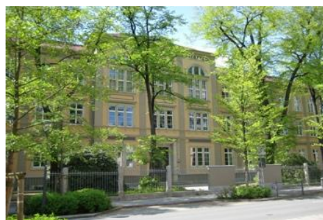
Philipp-Melanchthon-Gymnasium Bautzen, Schilleranlagen
